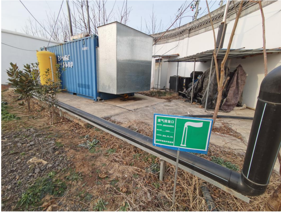
沼气发电机及排气筒
